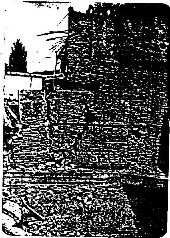
Desplazamientos de la cabeza del muro pantalla
