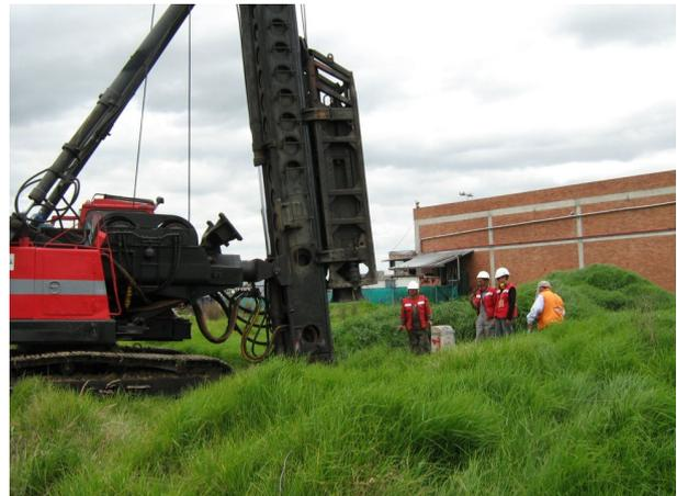
Foto No 2: Masa utilizada en las pruebas sobre los pilotes hincados. Masa de 6 ton de peso con una altura de caída de 0.80 m.
