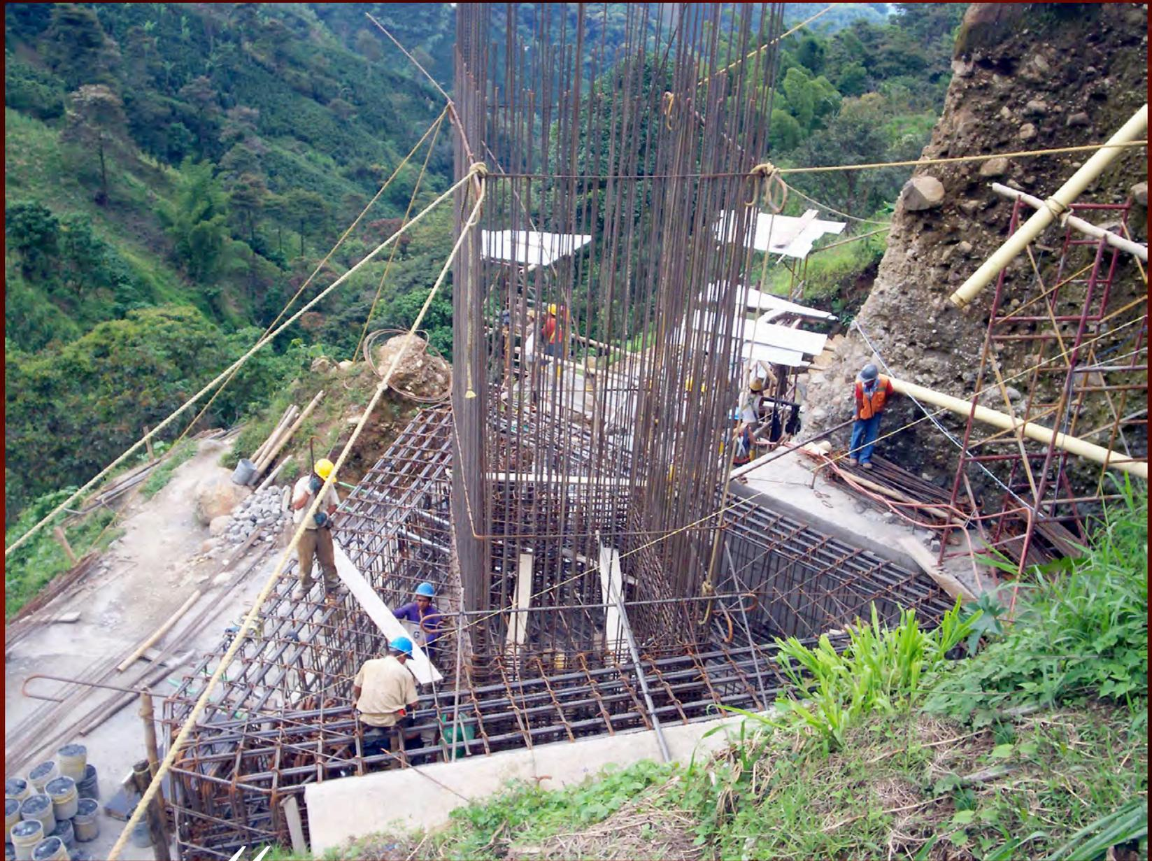
◀◀ Conjunto del refuerzo principal triangular de la zarpa, con la colocación del refuerzo del arranque de columnas.
