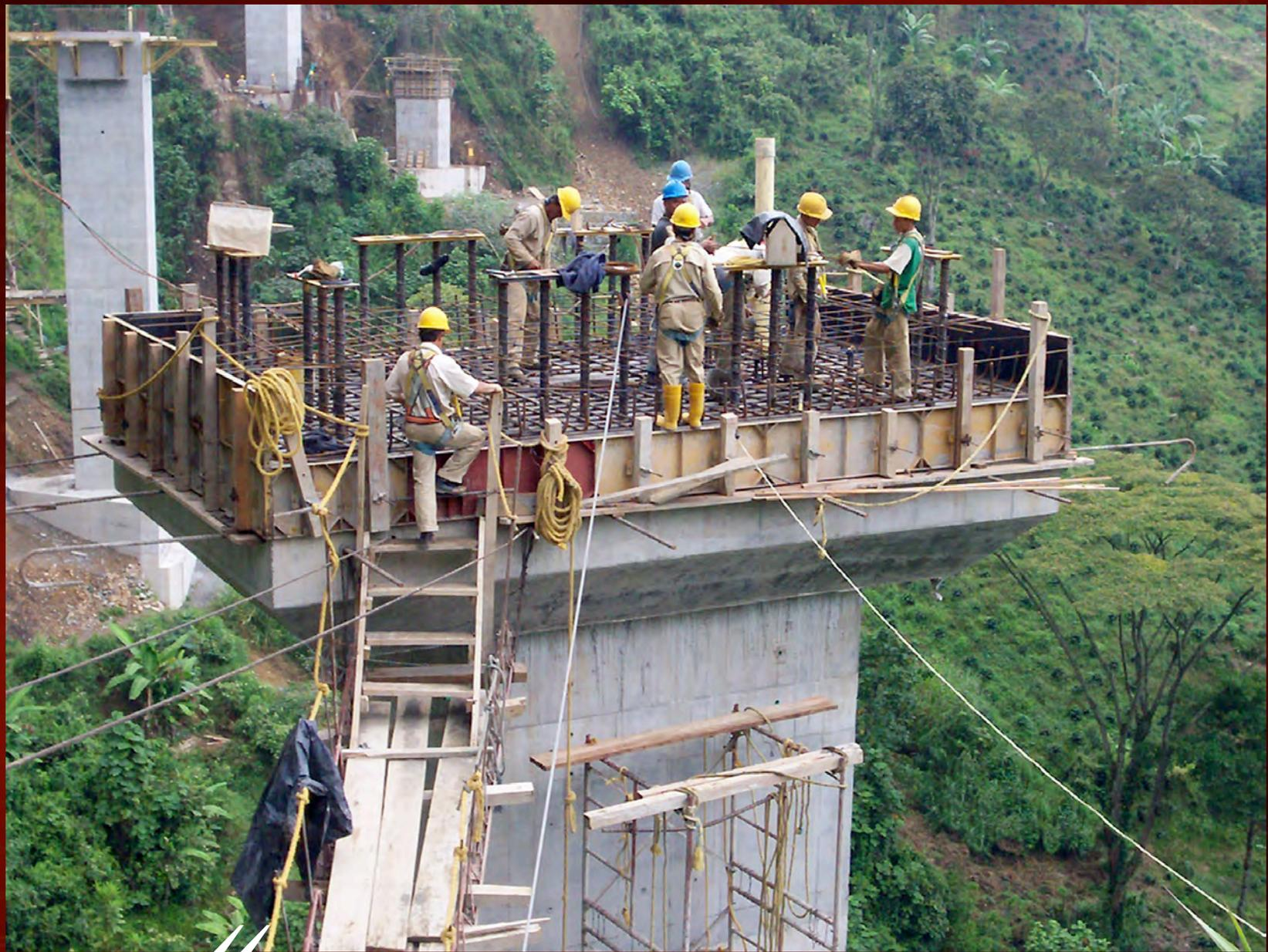
Armado del refuerzo de la parte inferior de la placa de abajo.
