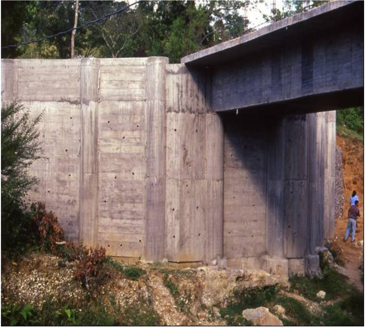
FOTOGRAFÍA Nº 2. ESTRIBO Y ALETAS PUENTE RÍO TIMBÍO
