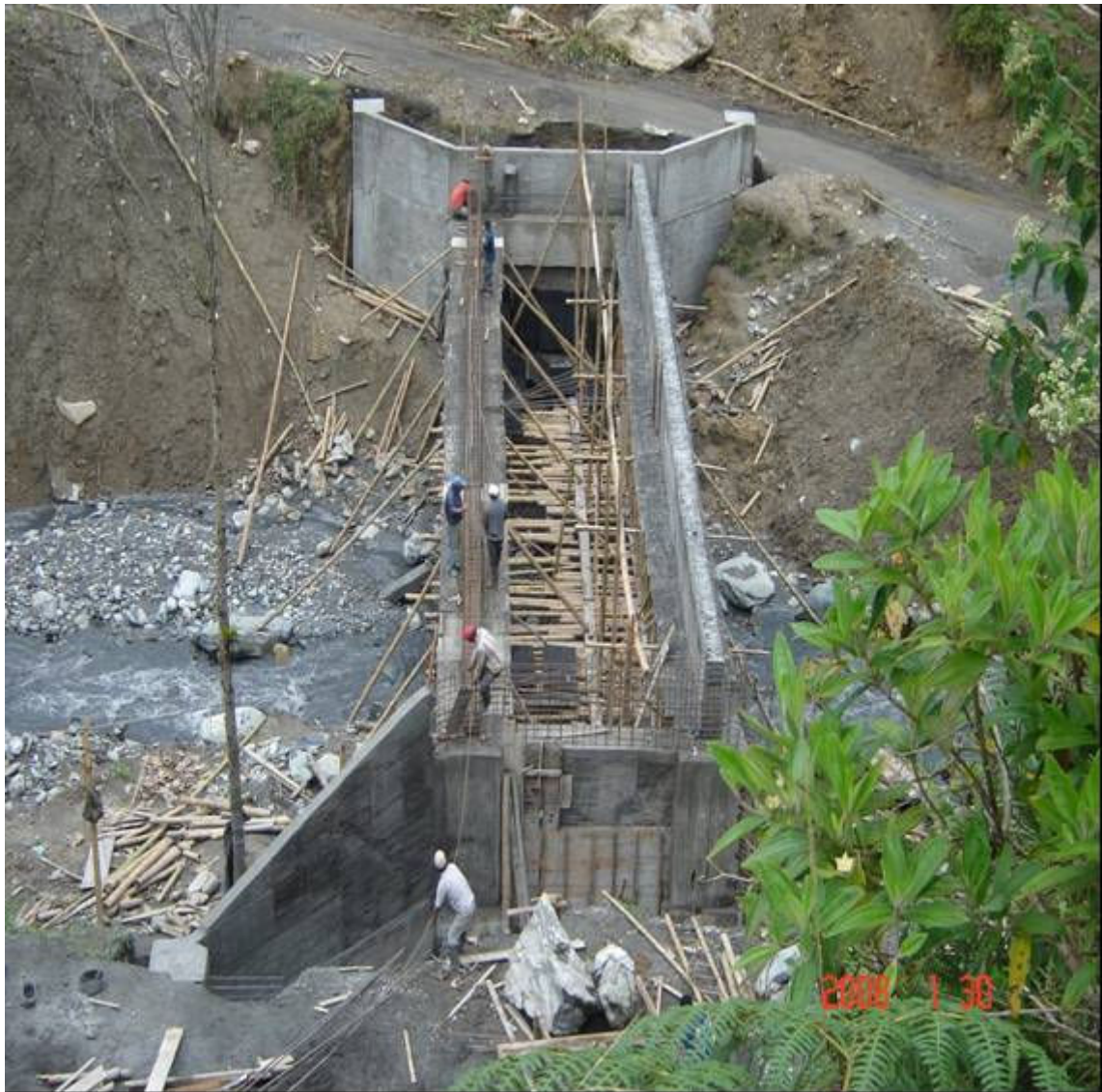
FOTOGRAFÍA Nº 3. ESTRIBOS Y ALETAS PUENTE GUANACAS.
