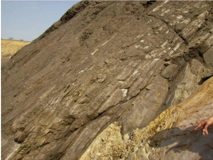
**FOTOGRAFÍA No. 2: FALLA PLANAR COMPUESTA EN EL TALUD BAJO DE UNA MINA DE CARBÓN**
