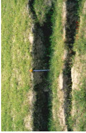
Asentamiento en Nantou
