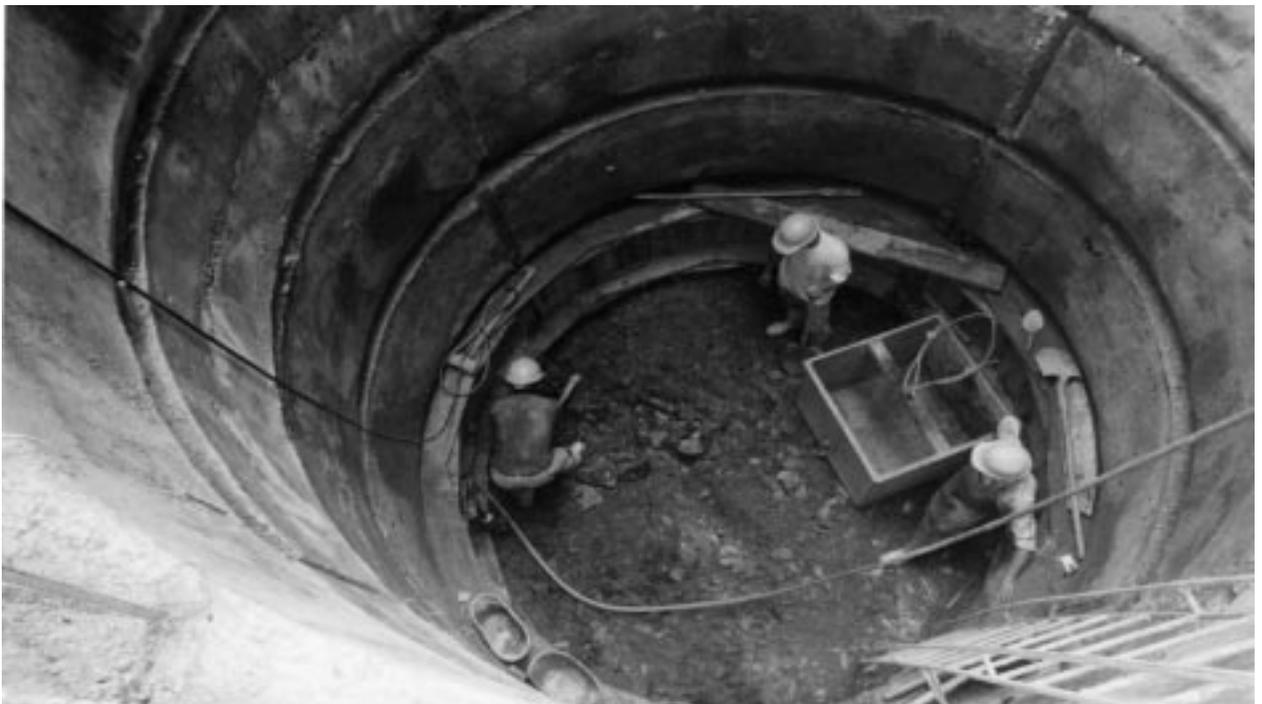
Figura 5. Detalle del proceso de excavación de los caissons.
