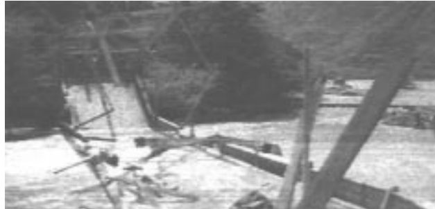
(a) Puente Pescadero – Vista de frente
