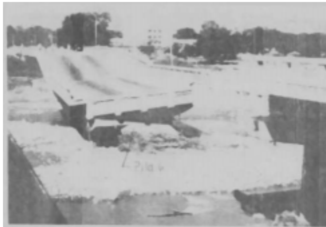
(b) Puente Jorge Gaitán Durán (Cúcuta)
