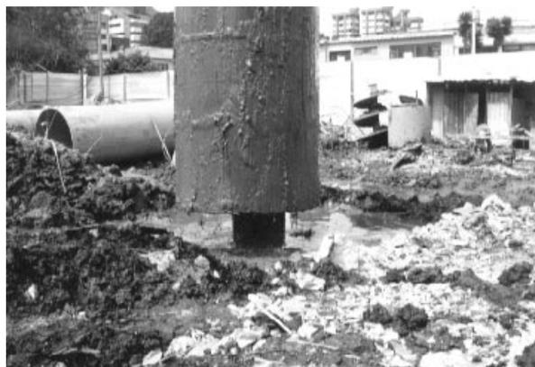
*Fotografía No. 5. Retiro camisa metálica. Nótese la columna metálica.*
