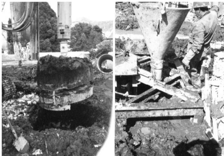
*Fotografías No. 1 y 2. Excavación y fundida de pilotes. Se observa máscara de instalación de las columnas metálicas*
