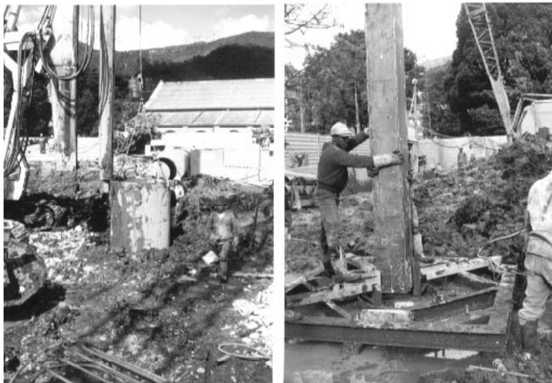
*Fotografías No. 3 y 4. Colocación camisa e Instalación columna metálica.*
