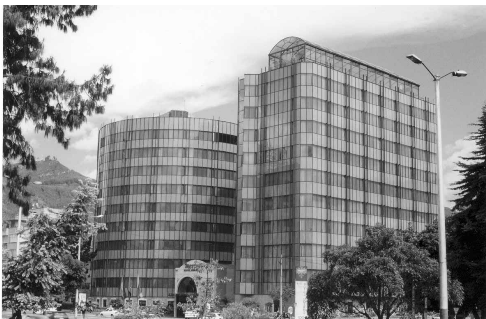
FOTOGRAFIA 3 HOTEL COMOS 100 – TORRES DE LAS ETAPAS I Y II VISTA DESDE EL NOR – OCCIDENTE
