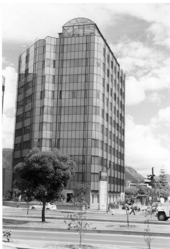
FOTOGRAFÍA 2 HOTEL COSMOS 100 – TORRE DE LA ETAPA II VISTA DE FRENTE
