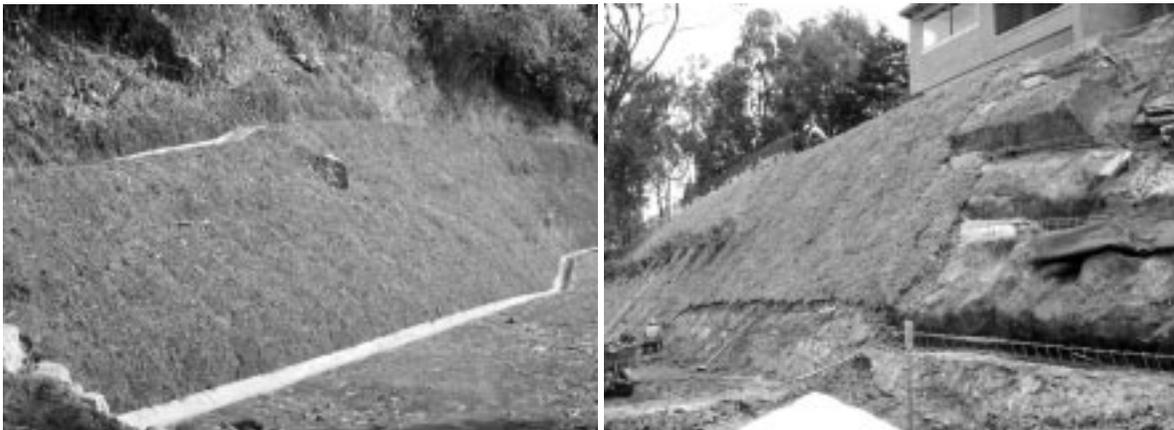
**Figura 1 – Vistas de dos ejemplos de soil nailing verde. Izquierda terminado y a la derecha en proceso de construcción.**
